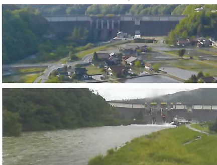
平水時(上)と増水時(下、2016年台風16号上陸時)の土師ダム
